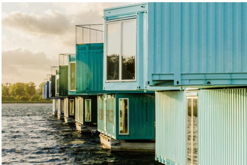
Figur 9. Billede af de 72 studieboliger bagfra der ligger i kanalen på Refshaleøen.
