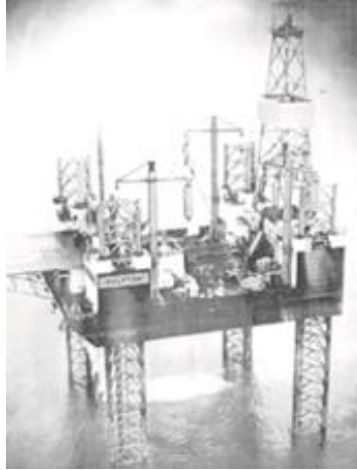
Figur 15. Jack-up olieplatform med ´truss´ ben.
