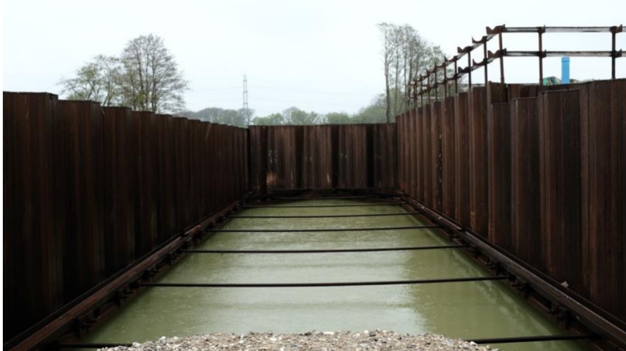
Figur 6: Sluse og Pumpestation ved Værebros Å
